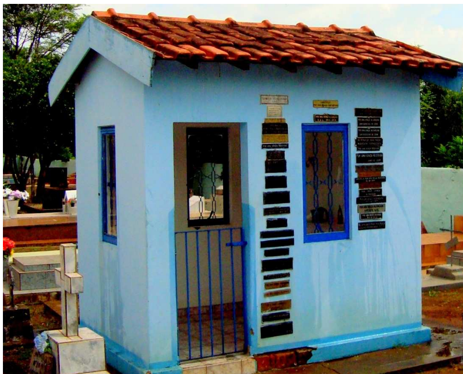
foto da capela Cemitério Municipal de Rincão- SP
